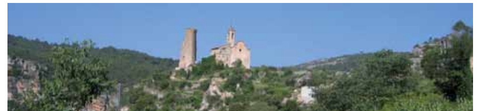
Sta Perpètua de Gaià
